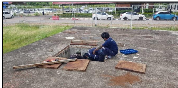
รูปที่ 2.2-23 ป่อดักไขมันหลังอาคารโรงอาหารและการทำความสะอาดป่อดักไขมัน
