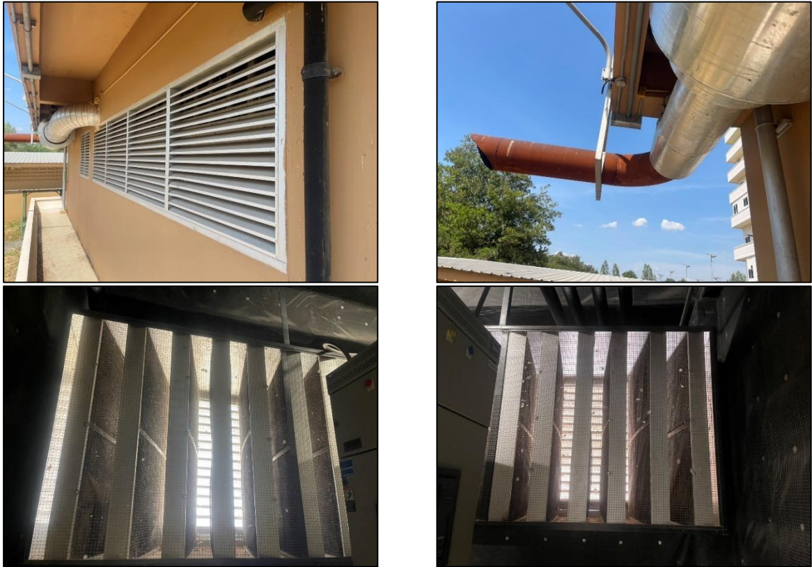
รูปที่ 2.2-15 ประสิทธิภาพอากาศ และพัดลมดูดอากาศภายในห้องเครื่องกำเนิดไฟฟ้า
