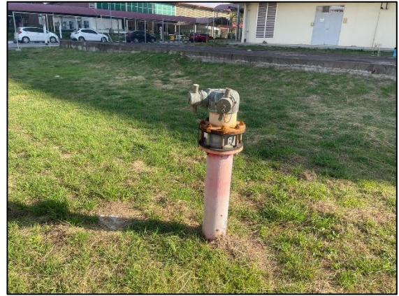
รูปที่ 2.2-38 หัวรับน้ำดับเพลิงจากภายนอกที่ชั้น 1
