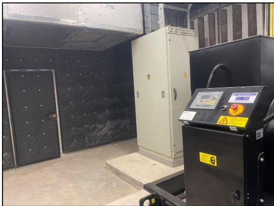
รูปที่ 2.2-7 ตำแหน่งห้องเครื่องสำรองไฟฟ้าภายในโครงการ และผนังห้องเครื่องสำรองไฟฟ้า
