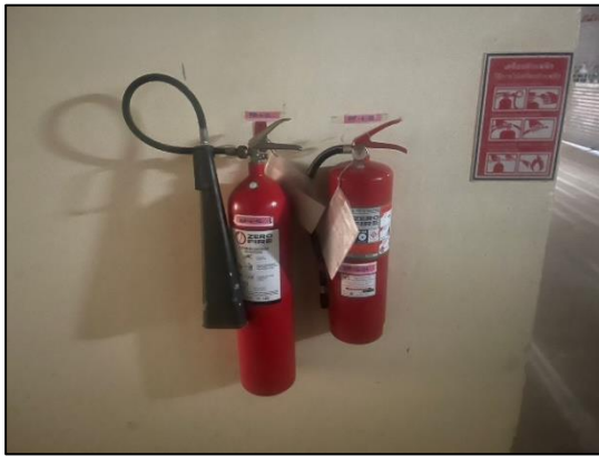
รูปที่ 2.2-36 ถังดับเพลิงเคมีชนิดมือถือ (ต่อ)
