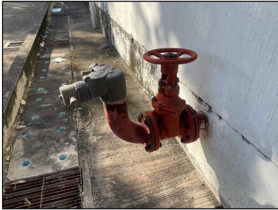
รูปที่ 2.2-38 หัวรับน้ำดับเพลิงจากภายนอกที่ชั้น 1
