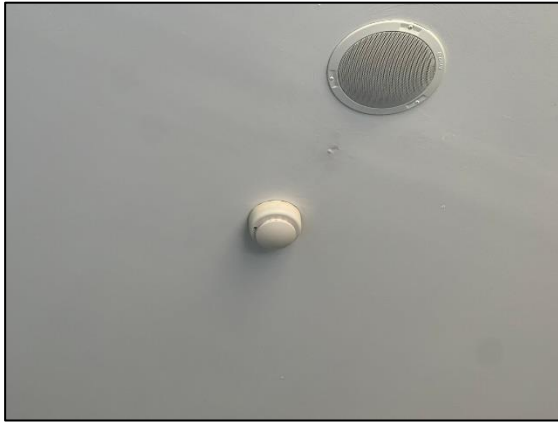
รูปที่ 2.2-34 เครื่องตรวจจับควัน (Smoke Detector) ภายในโครงการ
