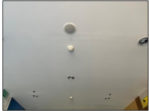
รูปที่ 2.2-34 เครื่องตรวจจับควัน (Smoke Detector) ภายในโครงการ
